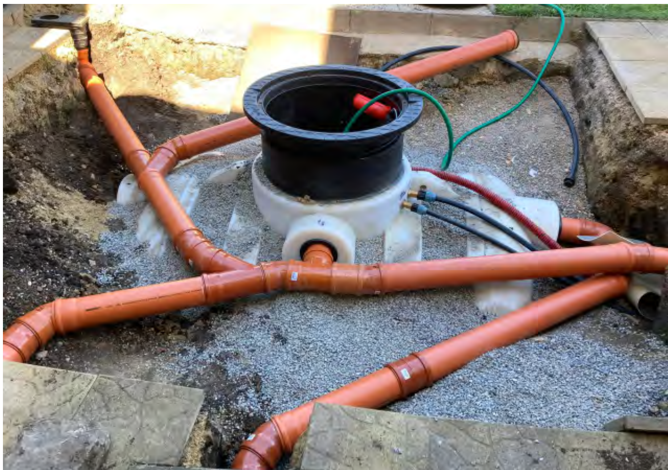
Ukázka průběhu instalace
